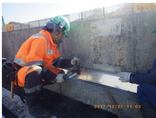
上部材の設置
