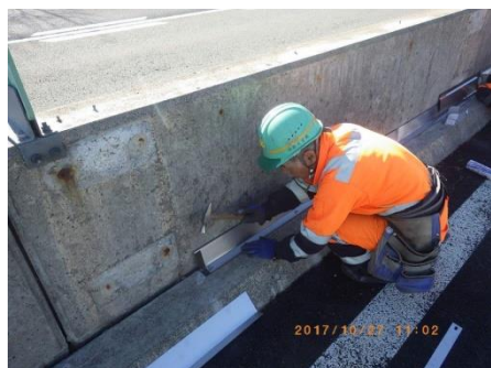
下部材の設置
